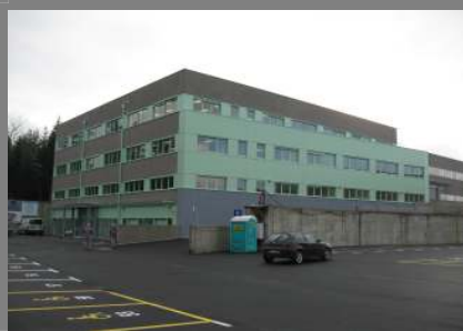
Tehnološki park C 2 Podbreznik, Novo mesto
