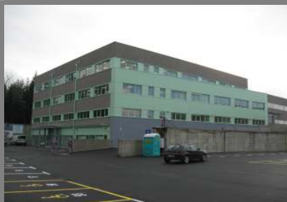
Tehnološki park C 2 Podbreznik, Novo mesto
