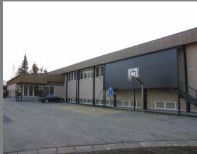
Rekonstrukcija in izvedba Šprotne dvorane, Črnomelj
