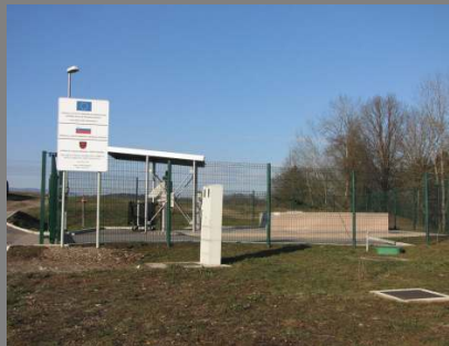
Fekalna kanalizacija in čistilna naprava, Dragatuš in Strai trg
